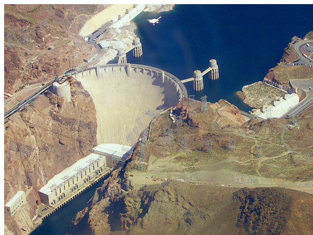
Hoover Dam, Colorado River, AZ/NV border Photo: Wikimedia Commons
